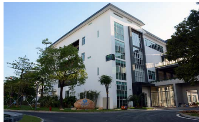
深圳领亚工厂 (冬藏楼)
